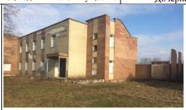
здание (инв. № 2) –1962 стены - частично м<sup>2</sup>, кирпичное, фундамент бутобетонный, перекрытия – ж/б плиты, крыша покрытие из тротуарной частично
