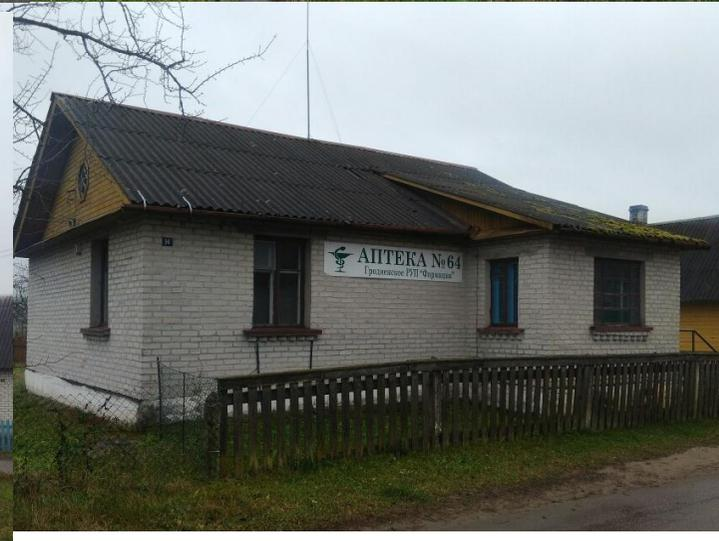
**Здание аптеки с двумя пристройками** щитовое, облицовано силикатным камнем; перекрытия – дерево, крыша – шифер, пристройки – 2 шт.: 1961 г.п., кирпичные, шифер, полы – плитка, окна, двери и г.п., Сзастр. – 3 кв.м, крыша – шифер, кв.м, фундамент – бутобетон, крыша – **забор (инв. № 61-417)** – 1961 г.п., **(инв. № 61-418)** - 1961 г.п., ж/б, глубина - 5 1961 г.п., асбестоцемент, L – 9,9 м с г.п., ж/б; глубина -2 м, d- 1 м.
