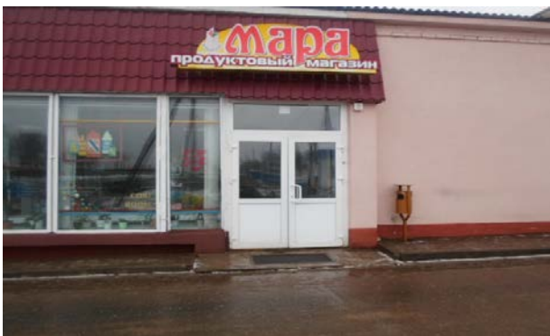
Здание магазина «Мара» Дятлово, ул. Победы Год постройки: 1973 Площадь здания (кв.м.): 202
