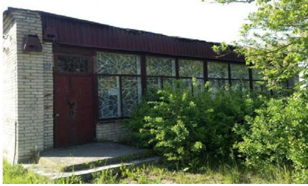
Здание магазина д.Девятковцы Год постройки: 1976 Площадь здания (кв.м.): 103,2 Площадь земельного участка (га.): 0,11
