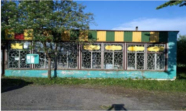
Здание магазина д.Яновичи Год постройки: 1976 Площадь здания (кв.м.): 98,1 Площадь земельного участка (га.): 0,09
