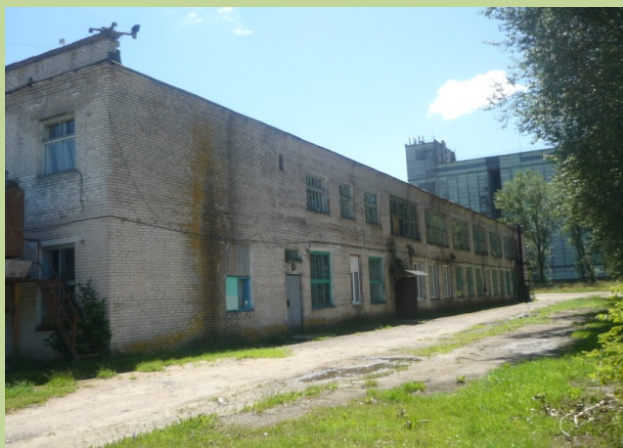
Склады первой очереди г.п.Новоельня, ул. Новогрудская д.15 Год постройки: 1973 Площадь здания (кв.м.): 11472
