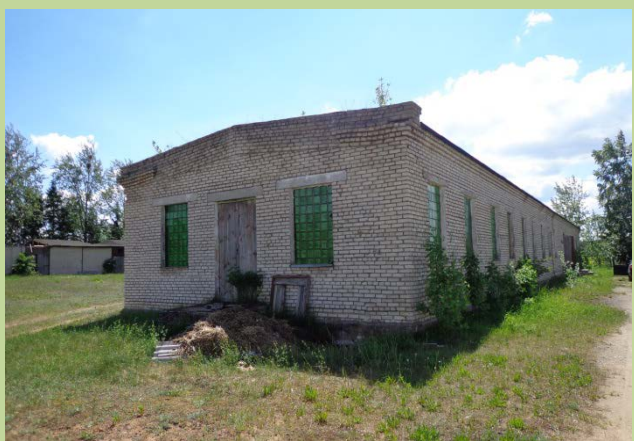
Здание квасильно-засоленного цеха п.Мельново Год постройки: 1973 Площадь здания (кв.м.): 416,1
