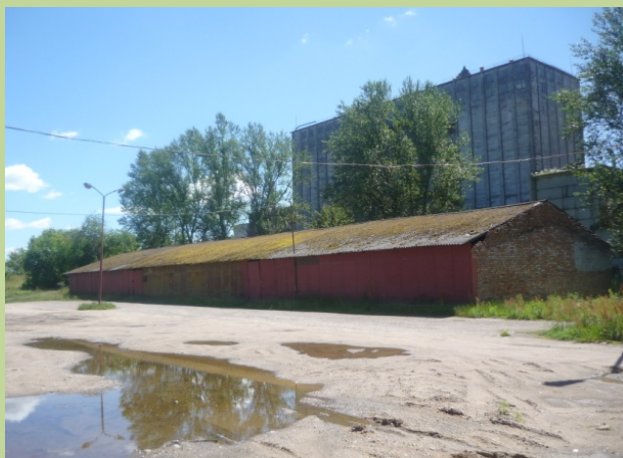
Склад металлический №5 г.п.Новоельня, ул. Новогрудская д.15 Год постройки: 1975 Площадь здания (кв.м.): 615
