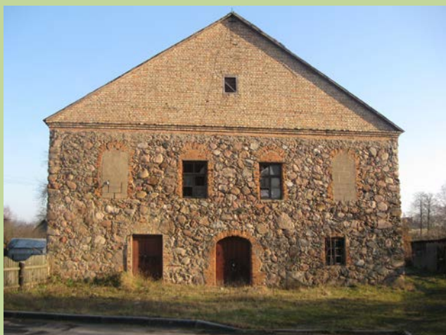
Здание склада двухэтажное г.п.Порозово Год постройки: 1964 Площадь здания (кв.м.): 473,8 Площадь земельного участка (га.): 0,1463
