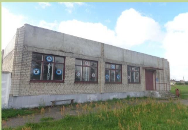
Здание магазина д.Потока Год постройки: 1975 Площадь здания (кв.м.): 150 Площадь земельного участка (га.):0.7
