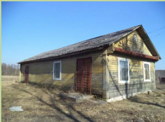
Здание магазина д.Лихачи Год постройки: 1970 Площадь здания (кв.м.): 89 Площадь земельного участка (га.): 0,0366
