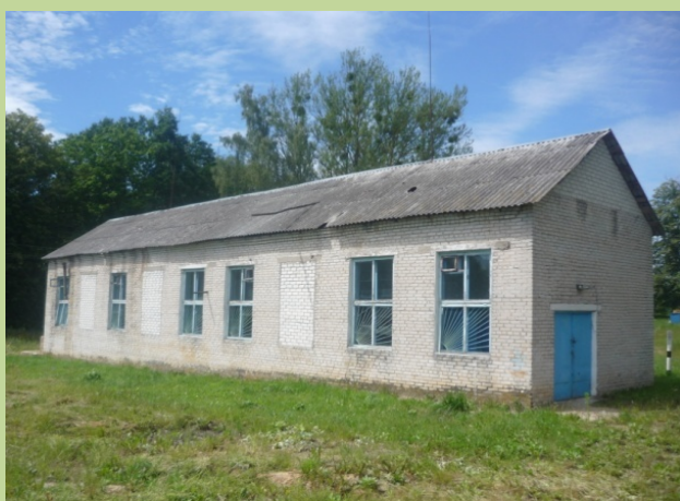
Здание кондитерского цеха г.п. Козловщина, ул. Советская 16А Год постройки: 1978 Площадь здания (кв.м.): 133 Площадь земельного участка (га.): 0,1311
