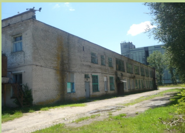
Здание АКБ 2-ой этаж г.п. Новоельня ул. Новогрудская д.15 Год постройки: 1973 Площадь здания (кв.м.): 4160
