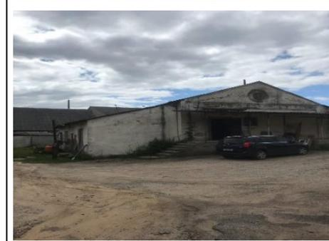
**Гаражи с пристройкой (инв. № 400/С-114061)** – одноэтажное здание 1971 г.п., S общ. 453,3 кв.м, крыша – рулонные материалы, перегородки – плита ж/б, стены-кирпичи. *Составные части и принадлежности: пристройка* (крыша-шифер, стены-кирпичные).
