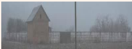
Одноэтажное здание пристройки д. Ревки Площадь здания (кв.м.): 40,0
