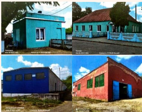
Комплекс зданий и сооружений аг. Рожанка, ул. Вокзальная, 18 Год постройки: 1964-1985 Общая площадь (кв.м.): 33 942,60 Площадь земельного участка (га): 8,7065
