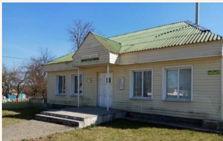
Здание комплексного приемного пункта аг. Гравжишки, ул. Советская, 25 Год постройки: 1965 Площадь здания (кв.м.): 90,3
