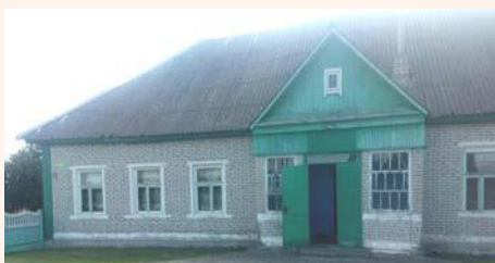
Здание Гравжишковского сельского дома семейного досуга аг. Гравжишки, ул. Советская, 33 Год постройки: 1959 Площадь здания (кв.м.): 213,3 Площадь земельного участка (га): 0,0624
