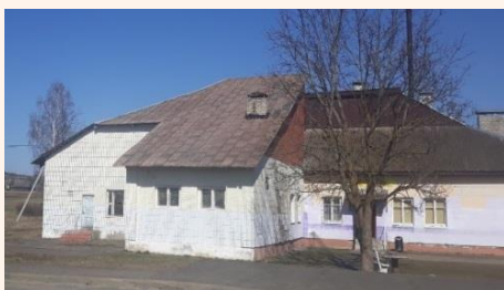
Здание бани аг. Жупраны ул. Юрия Гагарина, 1А Год постройки: 1986 Площадь здания (кв.м.): 161,1 Площадь земельного участка (га): 0,0848
