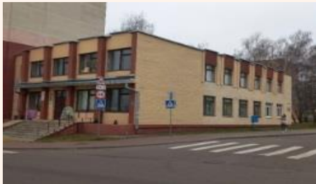
Изолированное помещение ( административно-производственное) г. Слоним, ул. К. Маркса, 42 Год постройки: 1979 Общая площадь (кв. м.): 579,2
