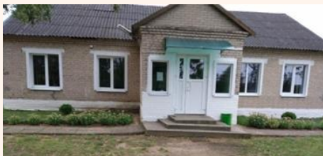
Здание филиала детской школы искусств аг. Деревянчицы, ул. Центральная Год постройки: 1997 Общая площадь (кв. м.): 120,2 Площадь земельного участка (га): 0,0608
